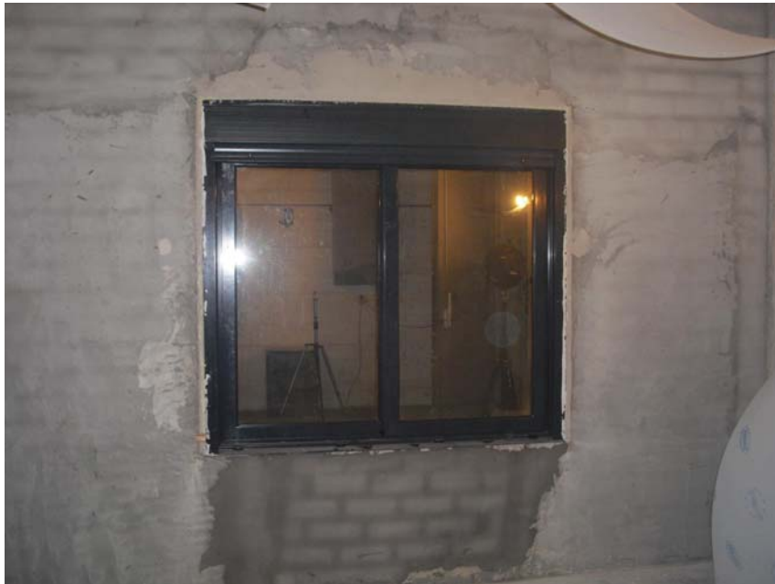
Vista desde la cámara emisora
