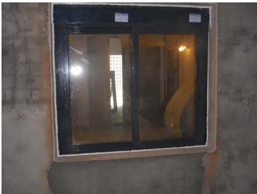
Vista desde la cámara receptora
